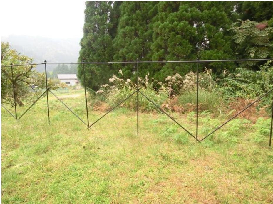
写真 7 : 耐雪仕様柵構造
